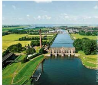
Das Unesco-Welterbe Woudagemaal ist das größte jemals gebaute Dampfwerk.
